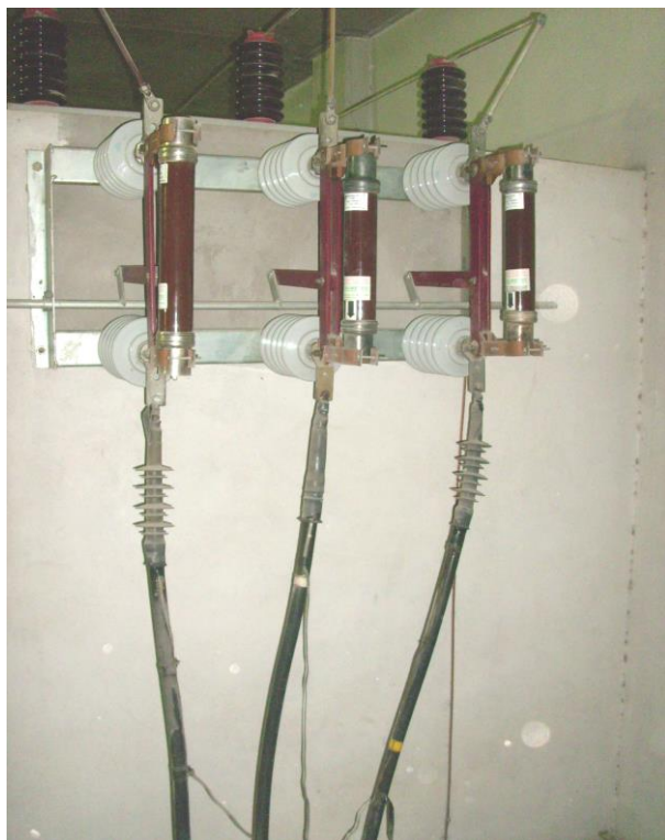
4° CUBÍCULO: VISTA DA SECCIONADORA TRIPOLAR DE MT – 25 KV COM FUS HH E DOS CABOS DE MT E TERMINAÇÕES.
