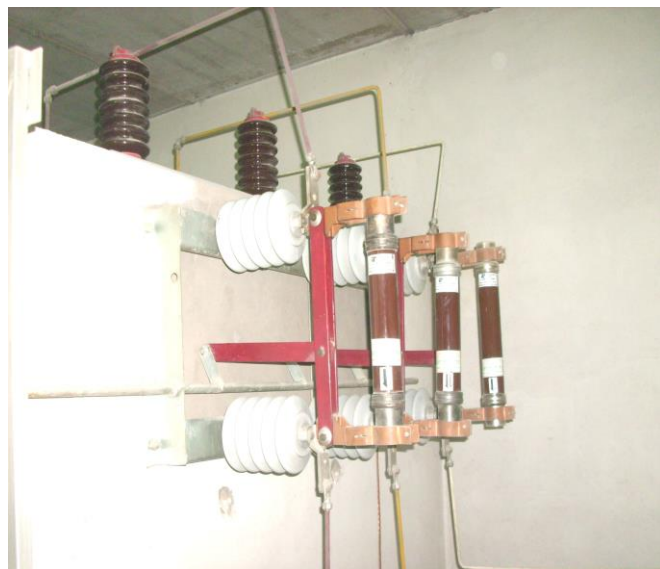
2° CUBÍCULO: VISTA DA SECCIONADORA TRIPOLAR DE MT – 25 KV COM FUS HH.
